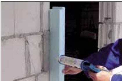
Fast-Bond - Verkleben von Hartschaumplatten auf Porenbeton
