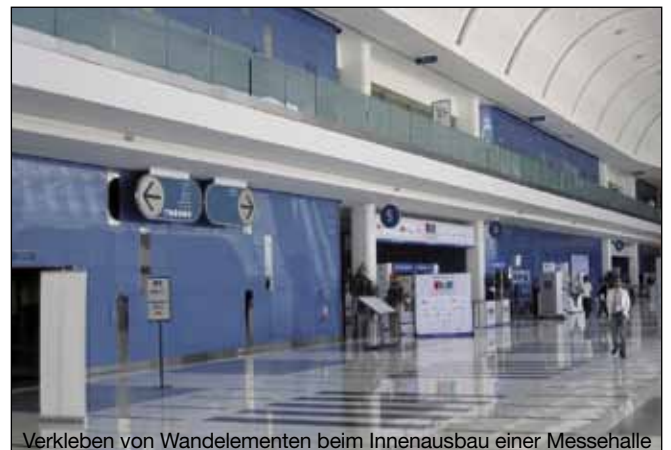
Verkleben von Wandelementen beim Innenausbau einer Messehalle
