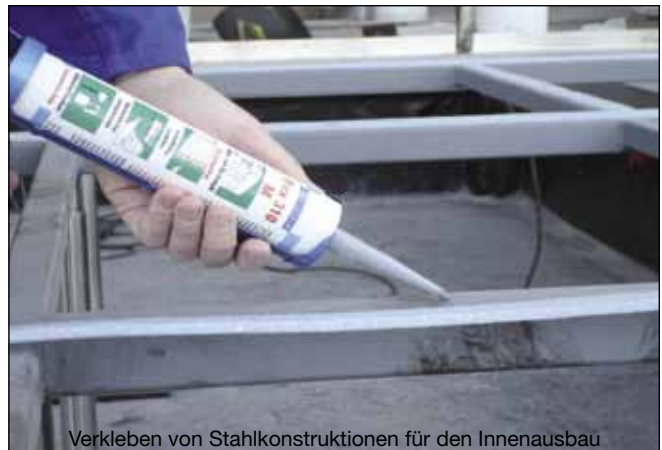
Verkleben von Stahlkonstruktionen für den Innenausbau
