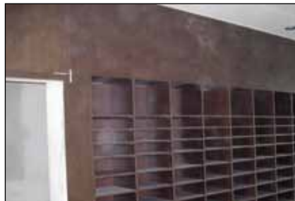
Speed-Flex - Verklebungen von Wandverkleidungen beim Innenausbau von Gebäuden
