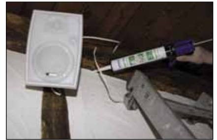
Flex 310 M Super-Haft - Fixieren von Leitungen
