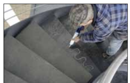
Flex 310 M Classic - Wendeltreppenstufe aus Stahl (Trittplatte aus Granitstein)
