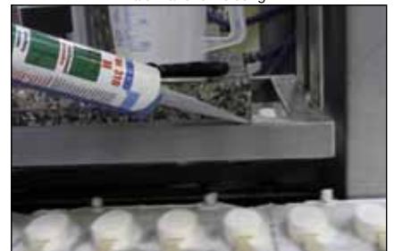
Flex 310 M Classic - Abdichten an einer Abfüllanlage in einer Eisfabrik
