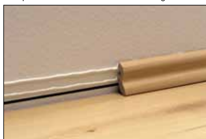
Fast-Bond - Verkleben von Sockelleisten
