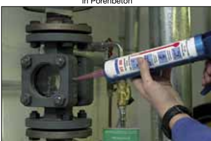
HT 300 - Abdichtung an Heizungsanlagen
