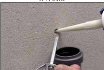
Fast-Bond - Einkleben eines Rohrschellenankers in Porenbeton
