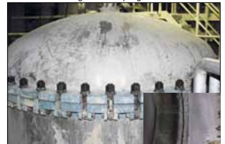
WEICON HB 300 - Reparatur eines Vertikalseichters
