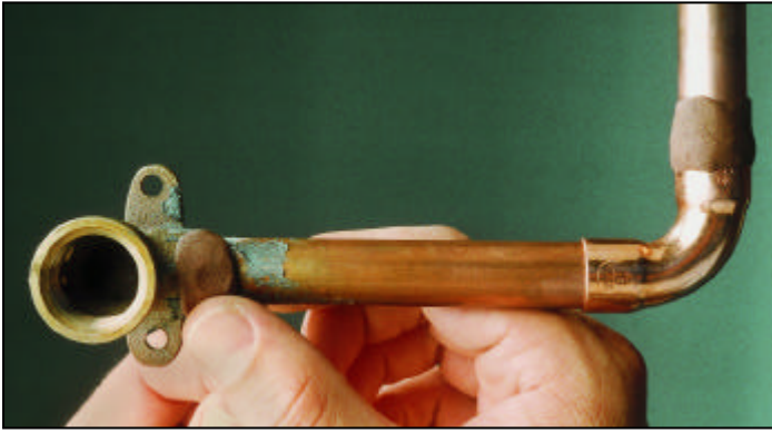
Abdichtung einer Leckage mit einem Repairstick
