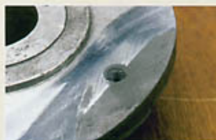
Die Flüssigmetall-Reparaturstelle wurde durchbohrt und mit einem Gewinde versehen.
