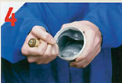
Im ersten Schritt muss der Inhalt in beiden Komponentendosen gründlich aufgerührt werden.
