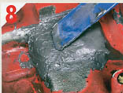
Mit dem Spachtel wird versucht, eine möglichst glatte Oberfläche zu erzielen.
